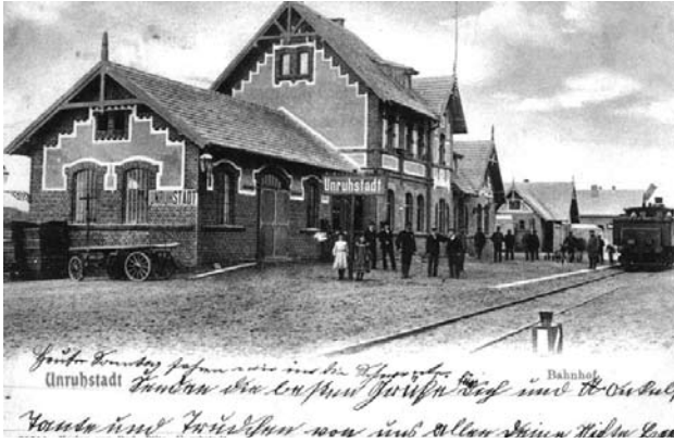
Dworzec kolejowy w Unrugowie w 1905 roku: karta pocztowa z początku XX wieku
