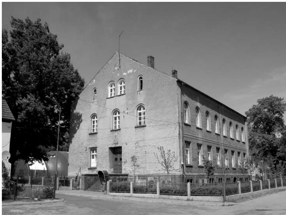
Budynek szkolny przy ulicy Szkolnej (obecnie siedziba gimnazjum)
