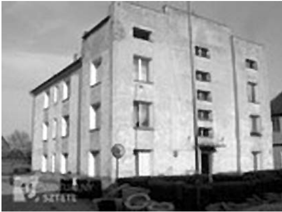
Budynek synagogi zaadaptowany na dom mieszkalny (widok współczesny)
