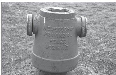
Hydrant koło szkoły.
