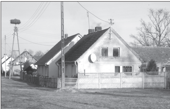
Dawny budynek remizy strażackiej.
