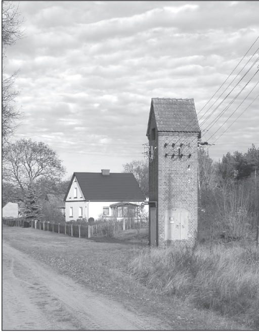
Transformator z lat 20. XX w.
