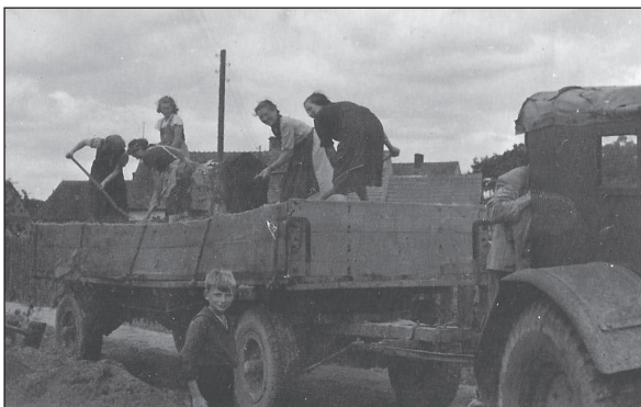
Prace przy budowie drogi w Karszynie, 1931 r.
